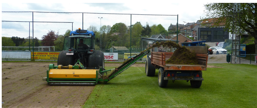
Remise à neuf de la pelouse par décapage
